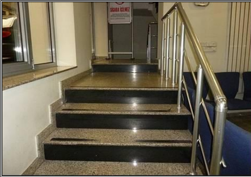
Zemin kattan katlara çıkan ara merdiven
