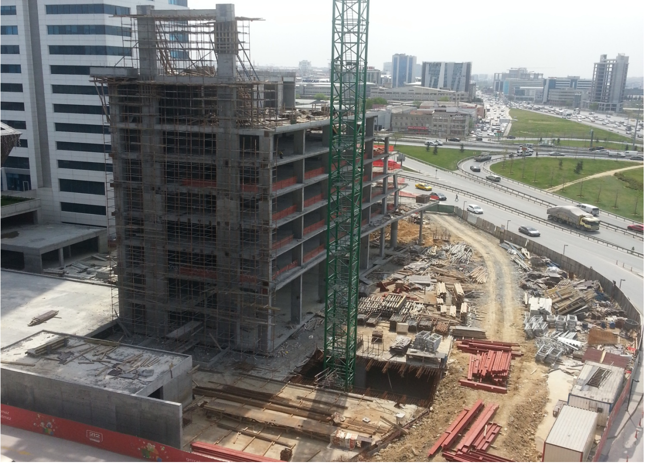
Otel inşaatı ilerleme durumu (Mayıs 2013)
