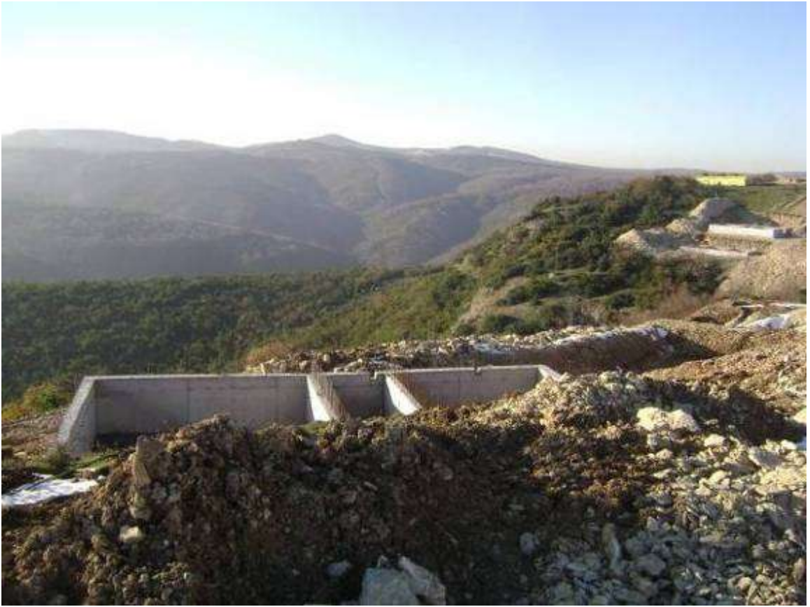
Şantiye sahasından görünüm
