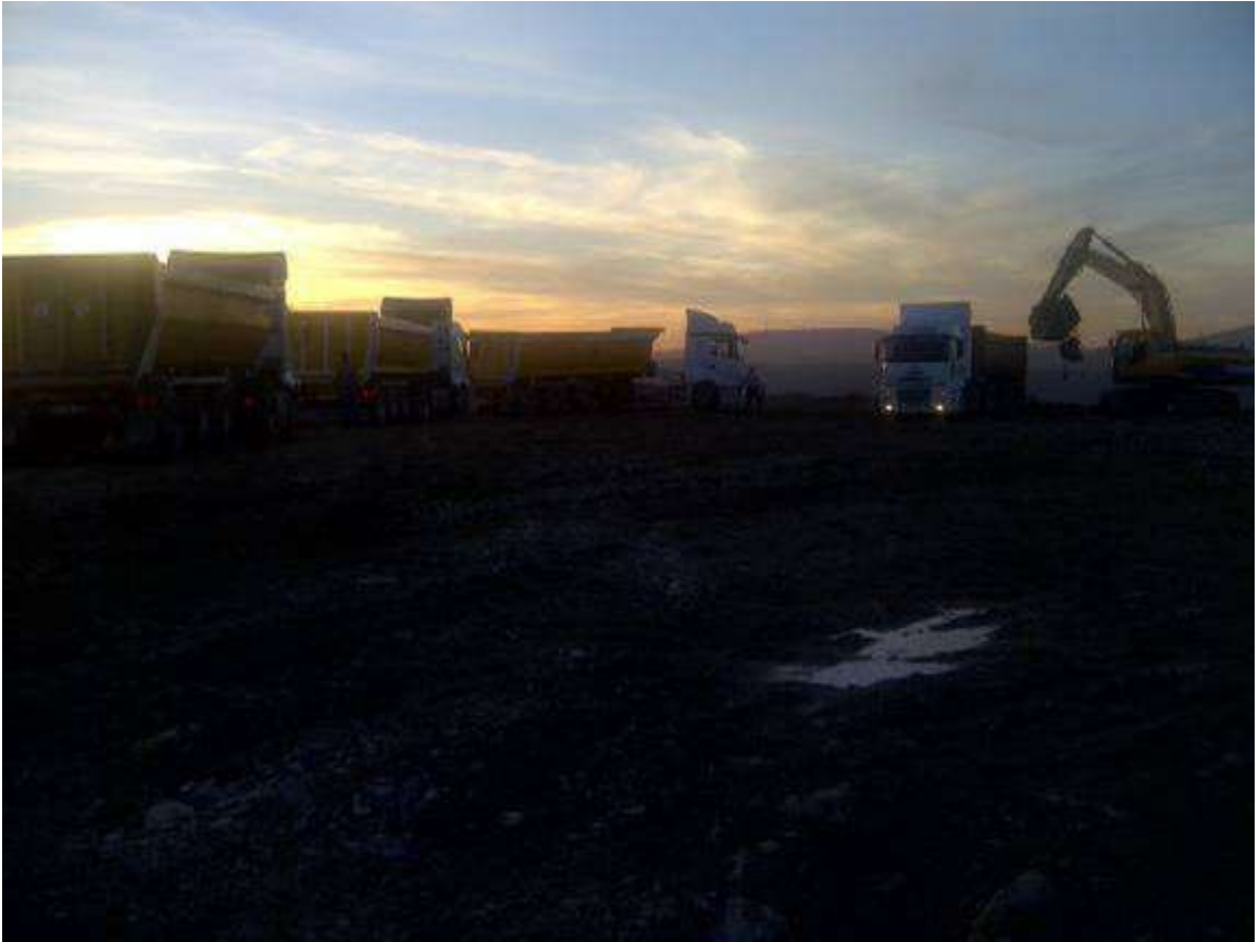
Şantiye sahasından görünüm
