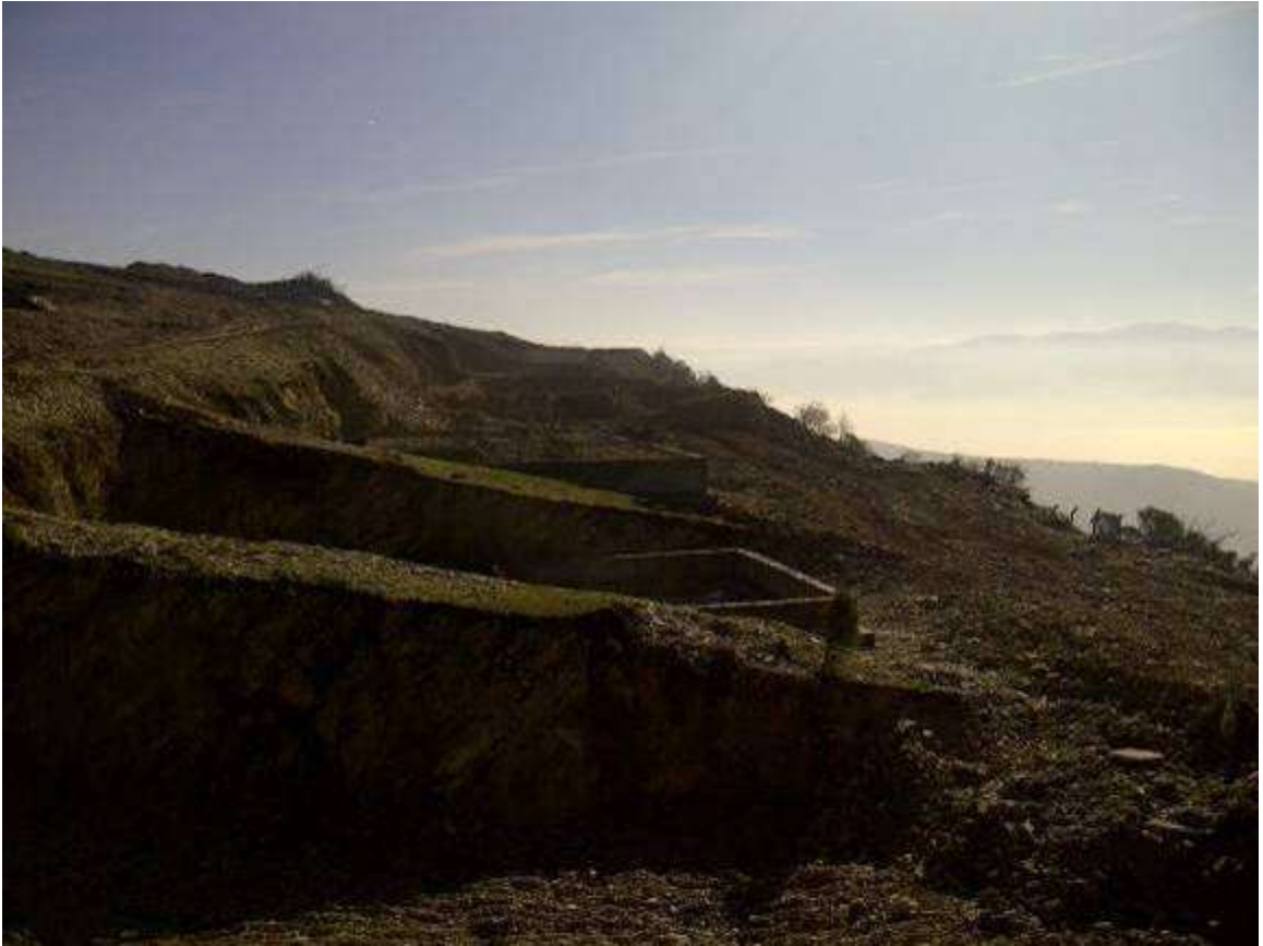
Şantiye sahasından görünüm
