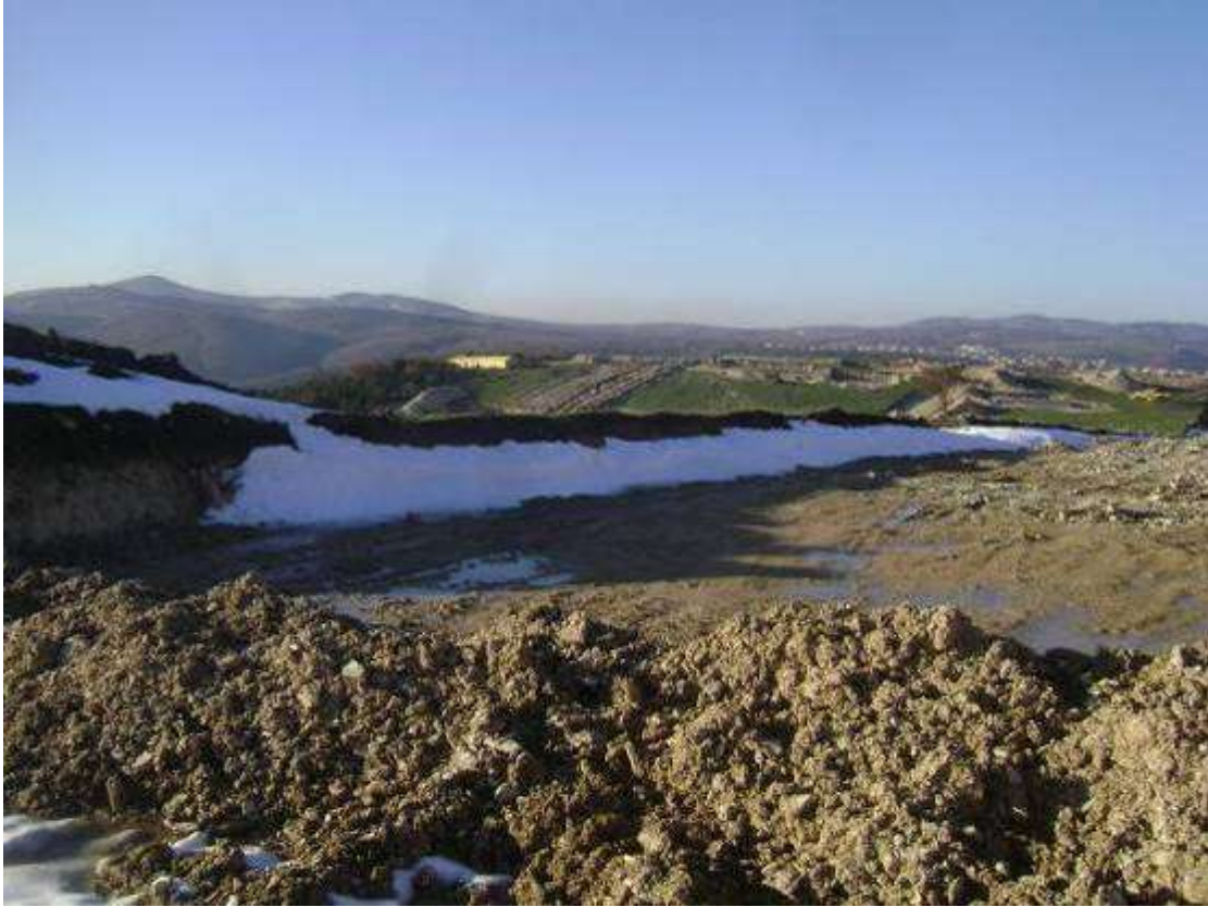
Şantiye sahasından görünümler
