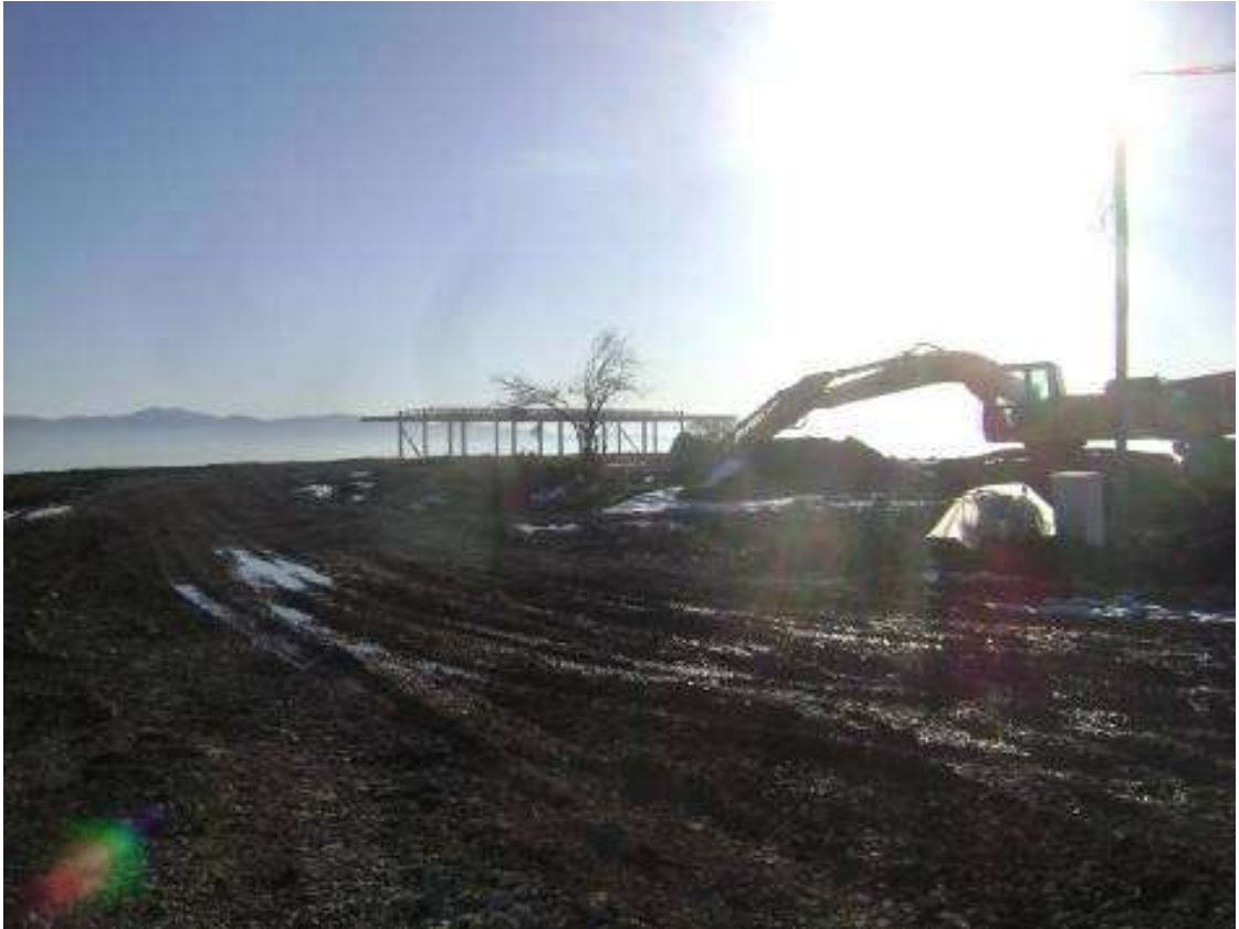
Şantiye sahasından görünüm
