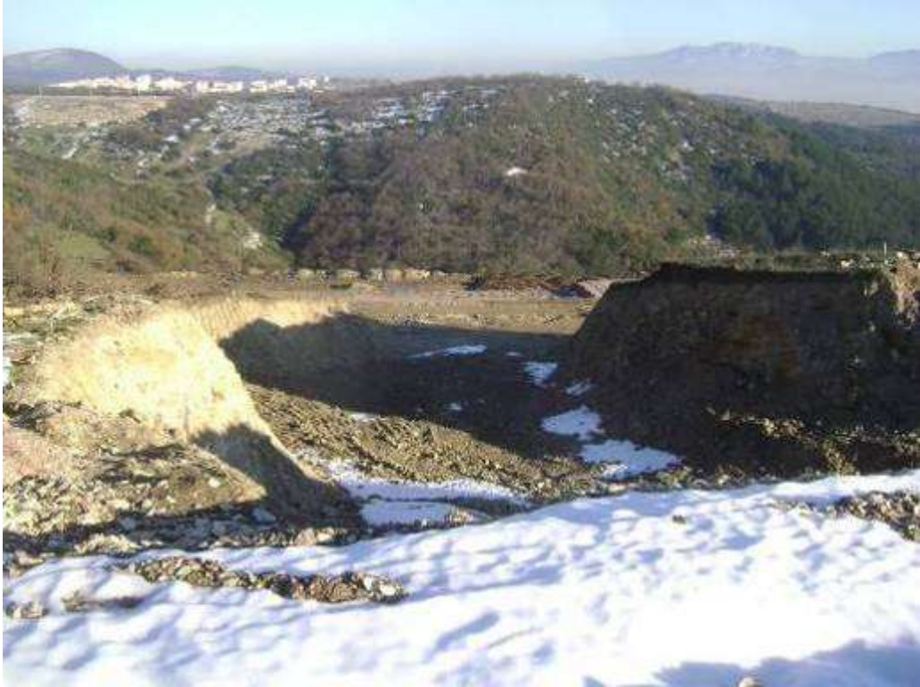
Şantiye sahasından görünüm
