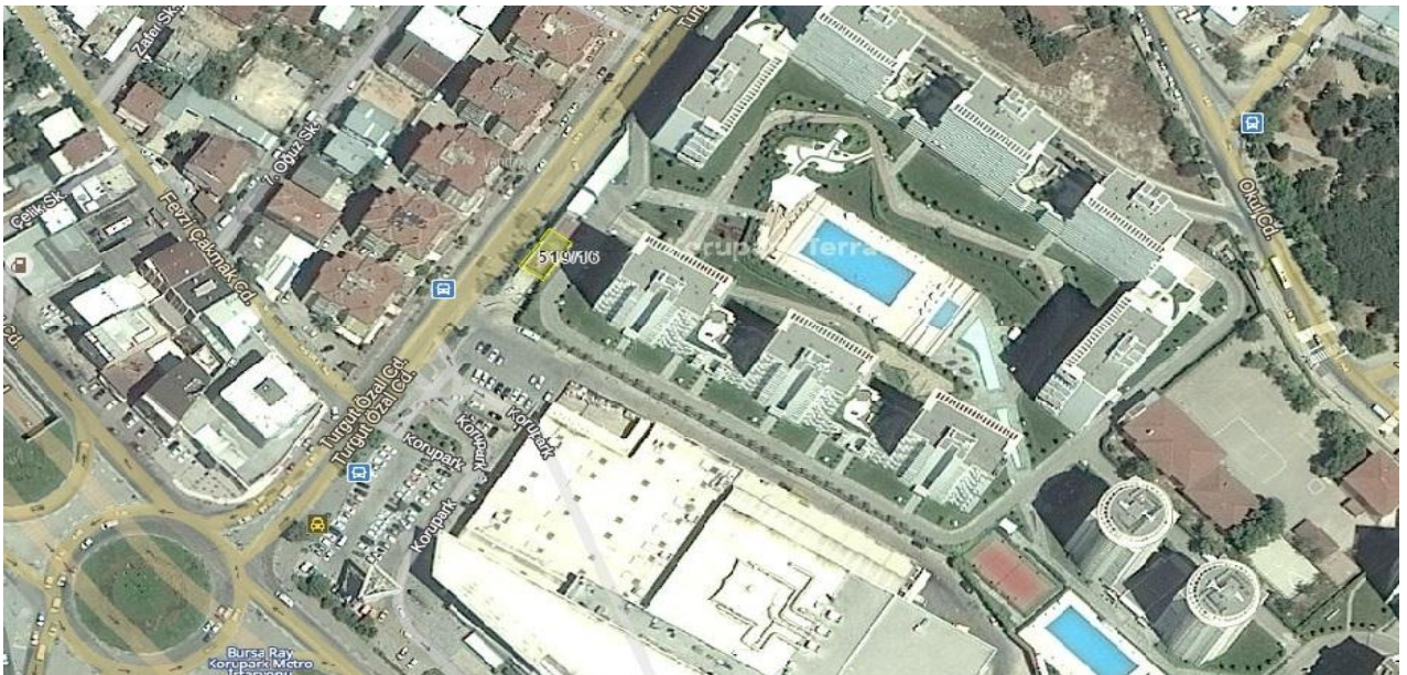
Korupark Trafo Yeri Uydu Görüntüsü (519 Ada-16 Parsel)
