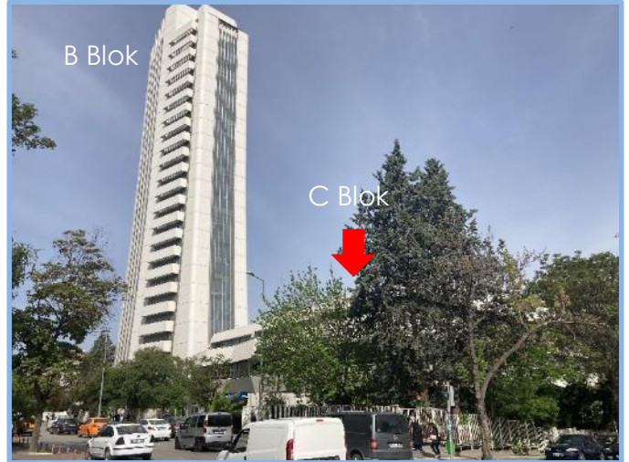
B Blok (Kule) ve C Blok Görünümü
