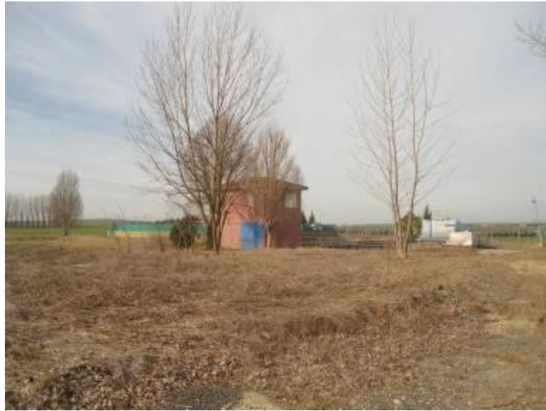
Arıtma Tesisi ve kontrol binası
