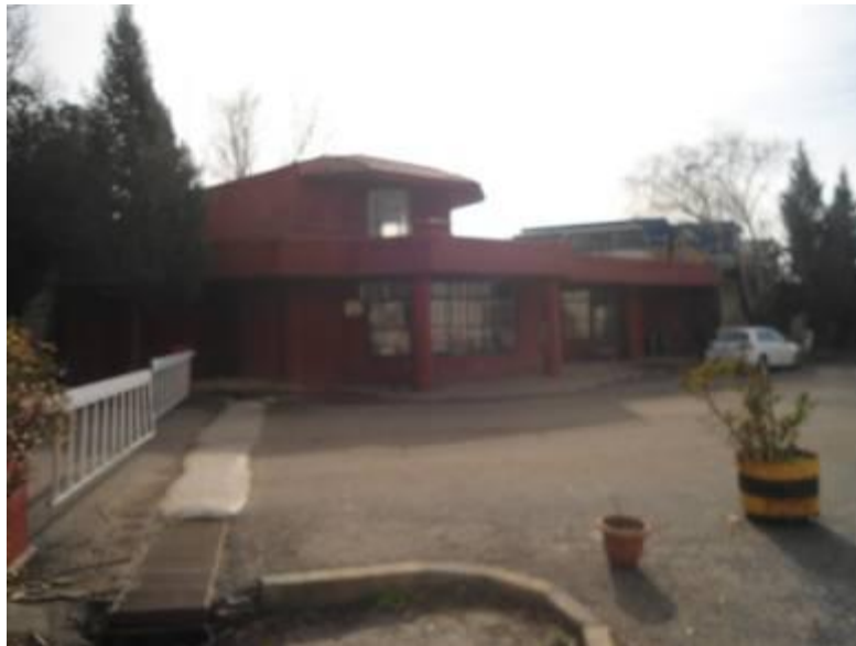
Güvenlik ve Personel giriş Binası
