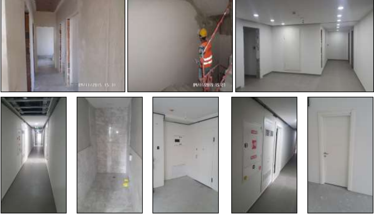
İnşaataın bir kısmında iç imalatlara ilişkin fotoğraflar.
