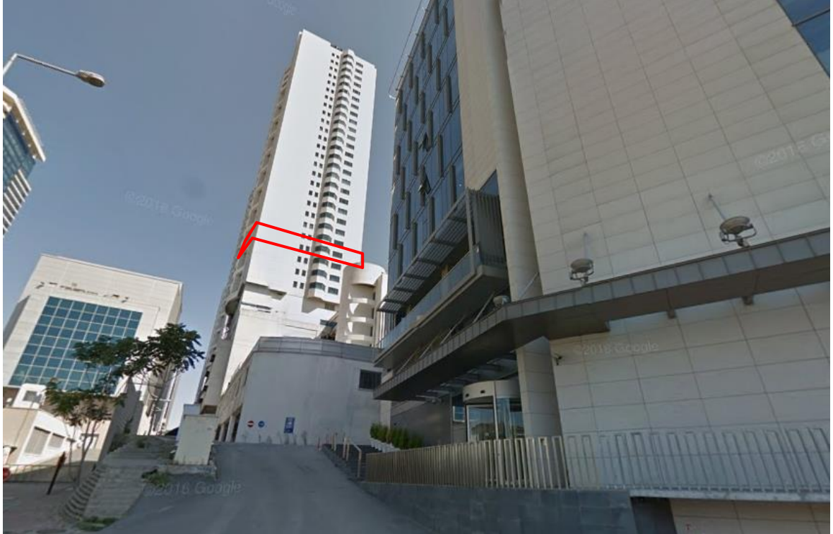
C BLOK DIŐ GÖRÜNÜM
