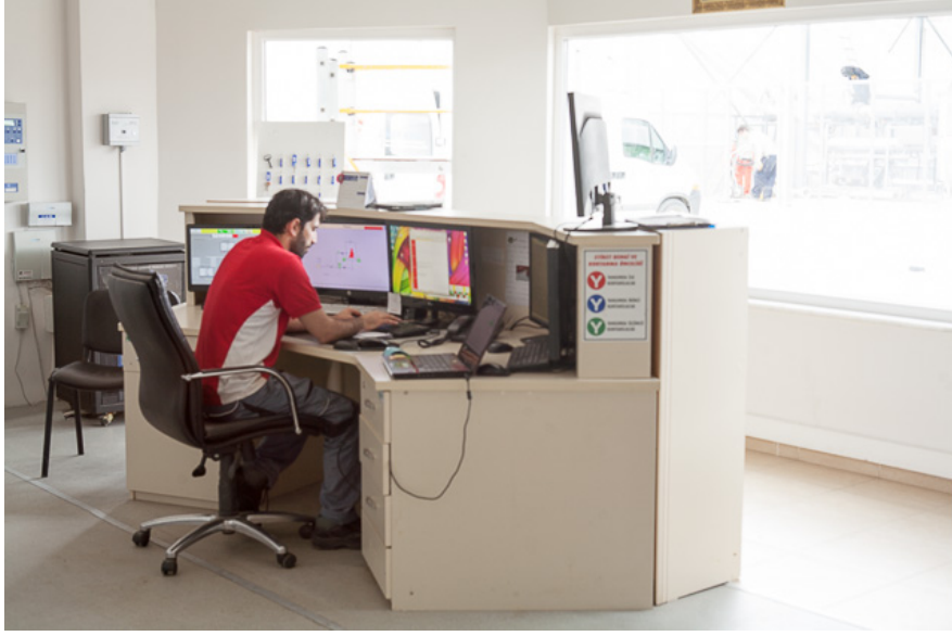
Şekil 4.3 Solaklar Tesisi Trafo Merkezi
