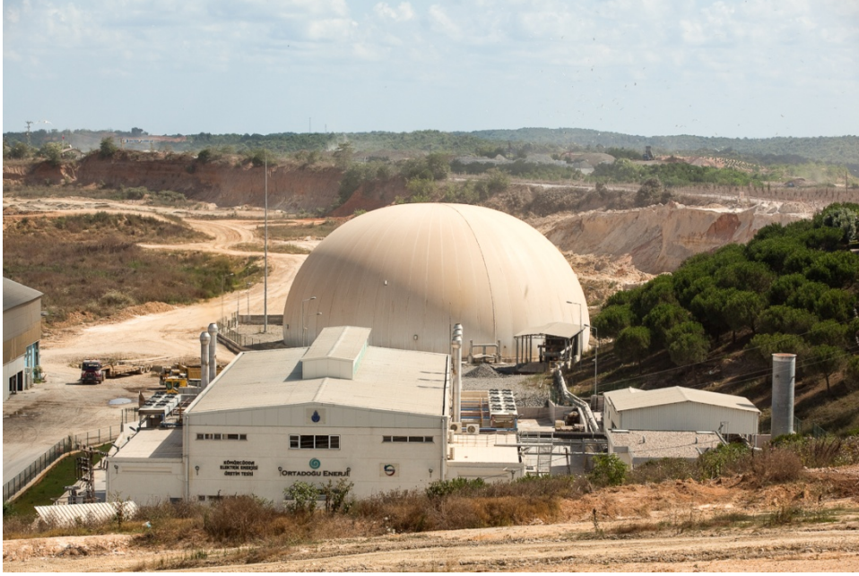
Şekil 4.7 Kömürcüoda Tesisi Gaz Depolama Balonu
