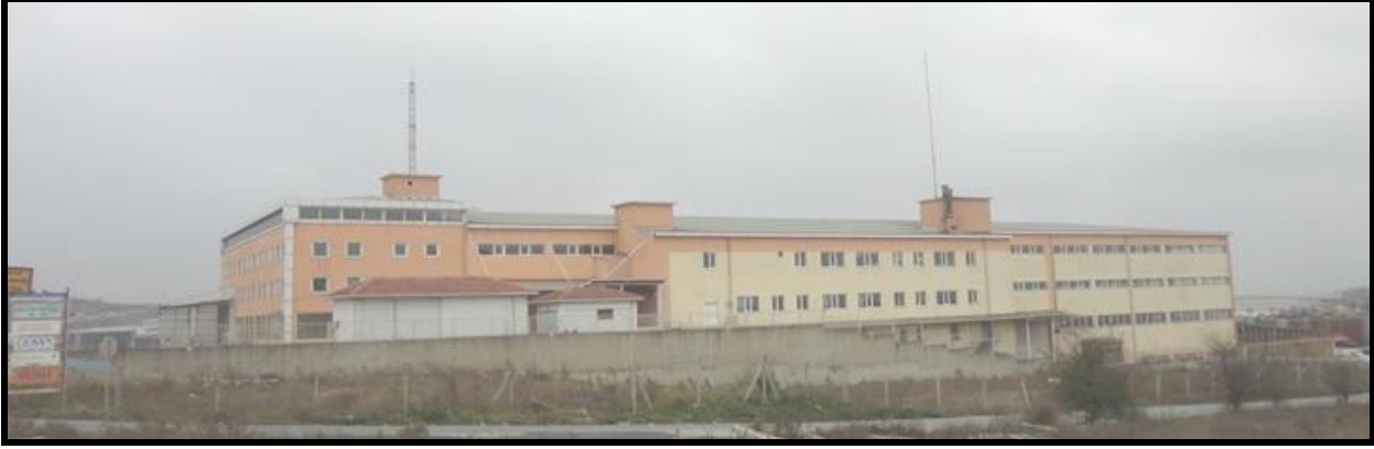
-Taşınmazın güneybatı cepheden görünüşü-
