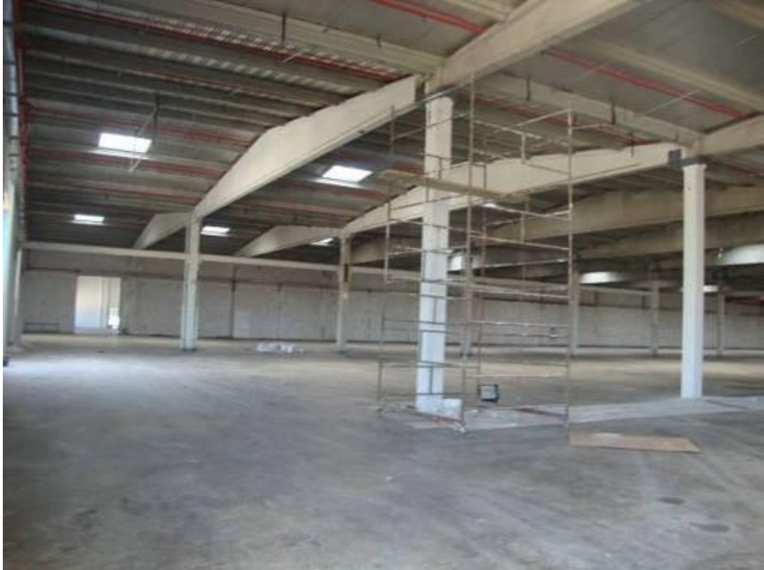
AK-AL 4 (AK-KİM depo binası/arşiv)
