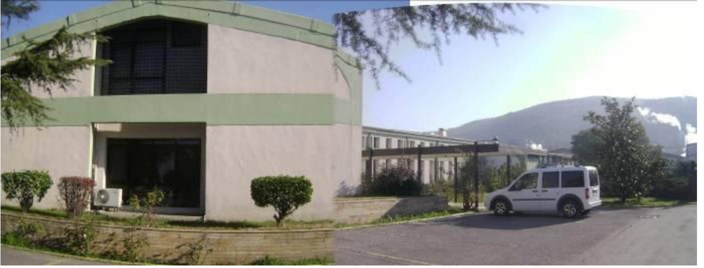
AK-AL 1/İdari bina-yemekhane binası
