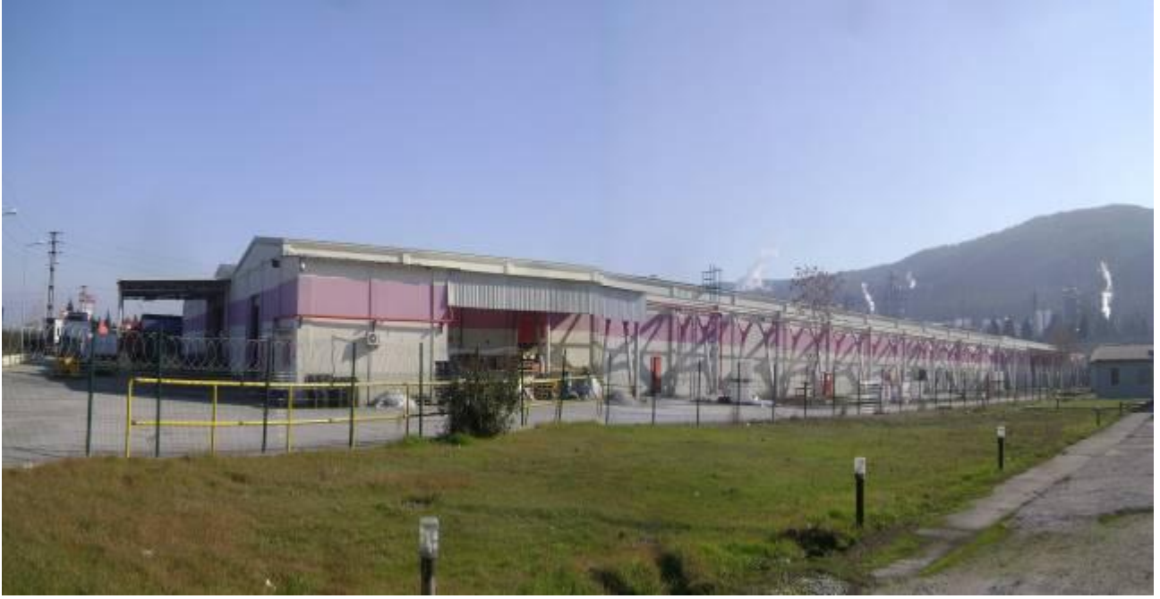
AK-AL 4 (AK-KİM depo binası)
