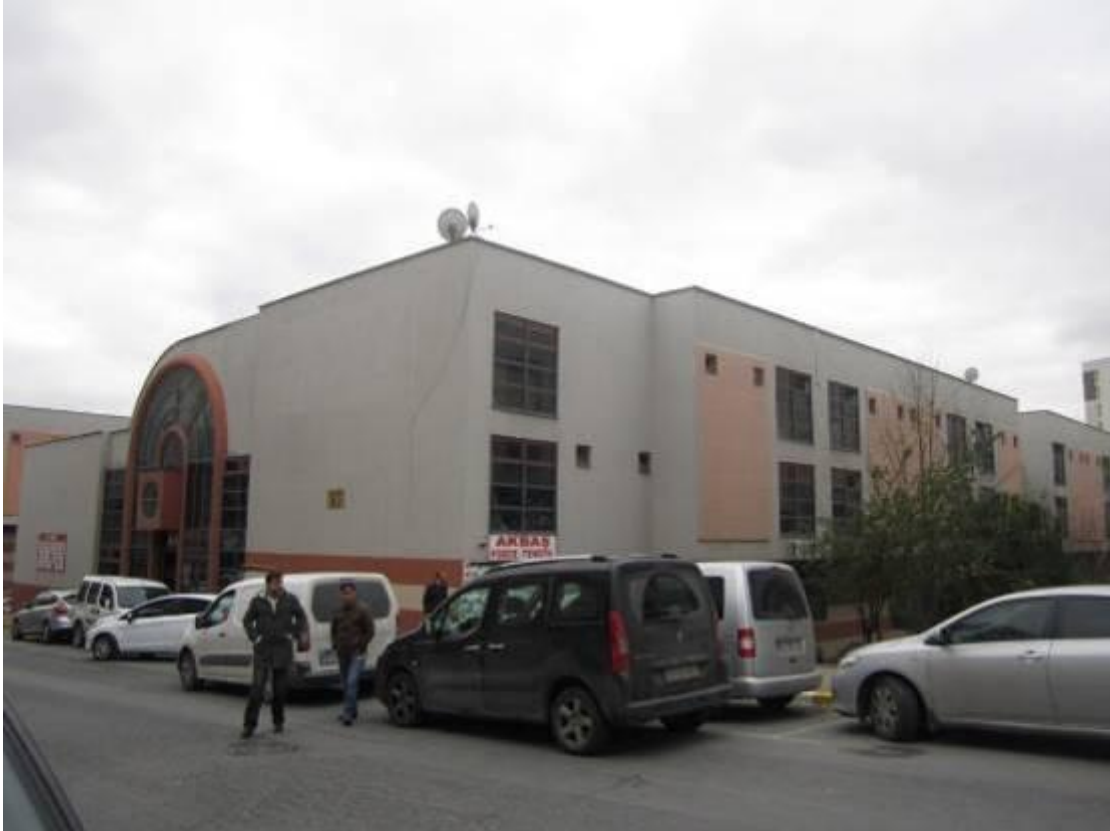
Taşınmazın yer aldığı A-3 Blokun Görünümleri
