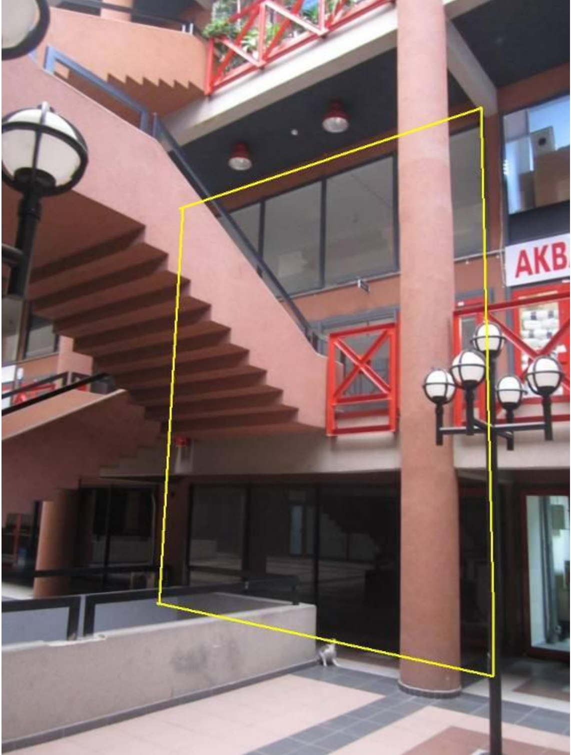
Taşınmazın bina ortak koridorundan görünümü
