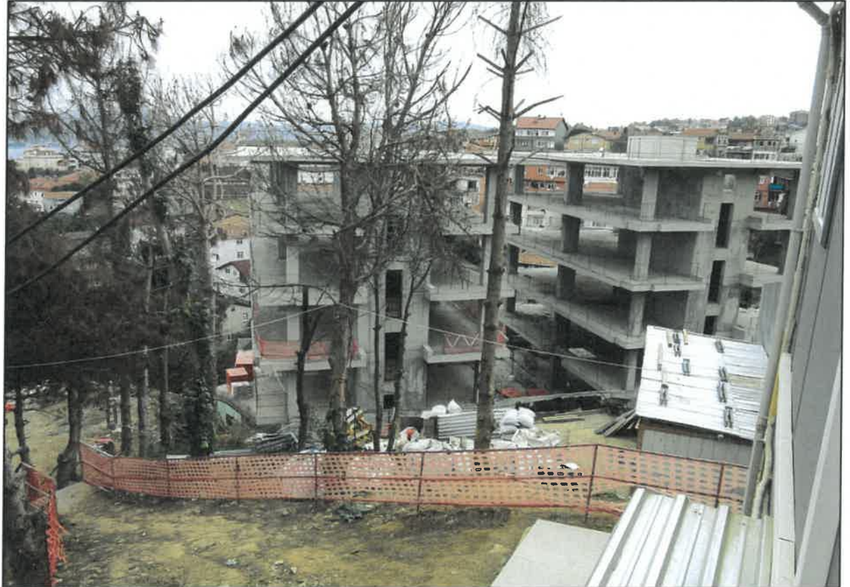
-89 parsel A ve B Blok inşaatı-
