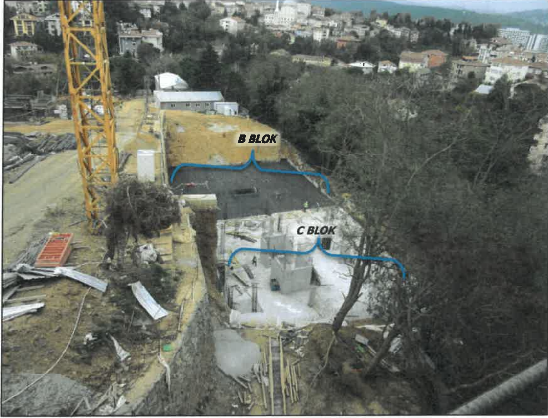
-82 Parsel B ve C Blok İnşaatları-
