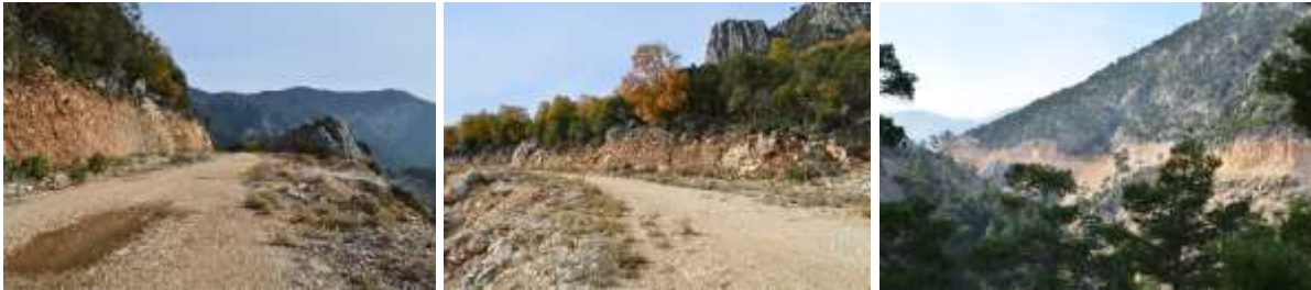
Regülatör ve Yükleme Havuzu arasındaki ~4.650 m. lik ham yoldan görünüm
