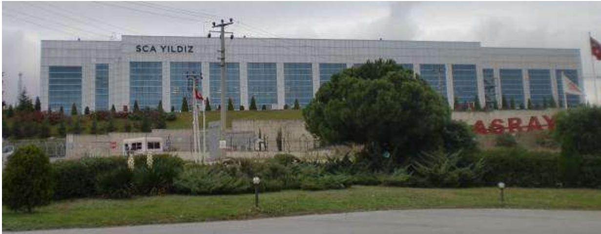
177 Ada 15 Parselin Güney Cepheden Görünüşü-Mevcut Durum
