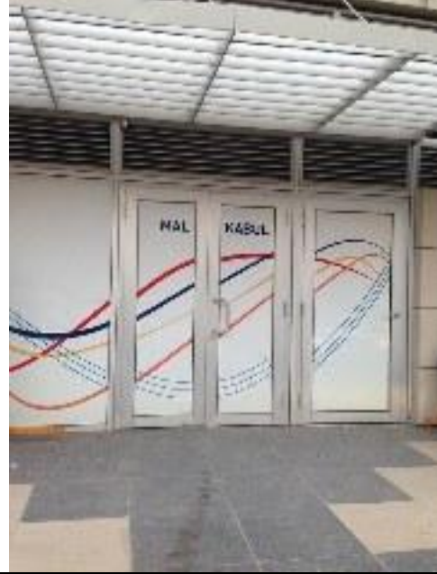
Mal Kabul Giriş Kapısı
