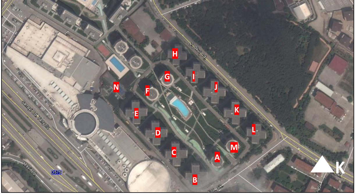
Korupark 1. ve 2. Etap Uydu Görüntüsü
