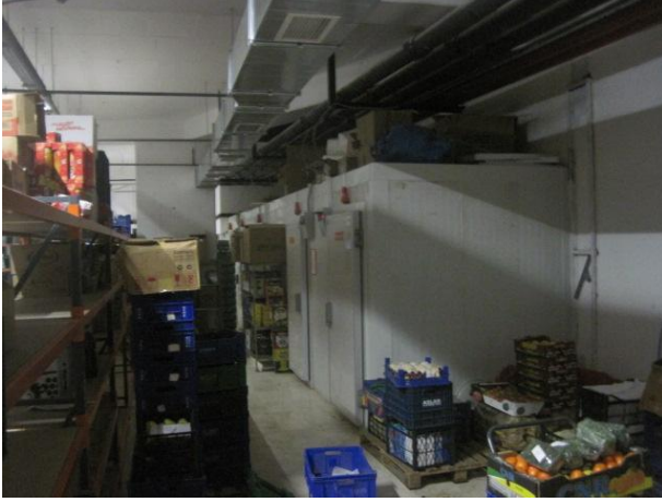
Depo Alanlarından Görünüm
