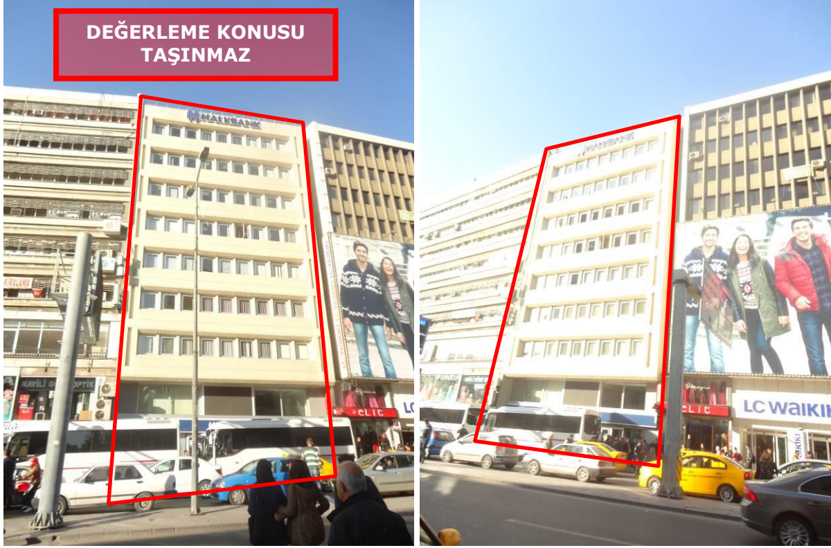
Bina Dış Görünüşü
