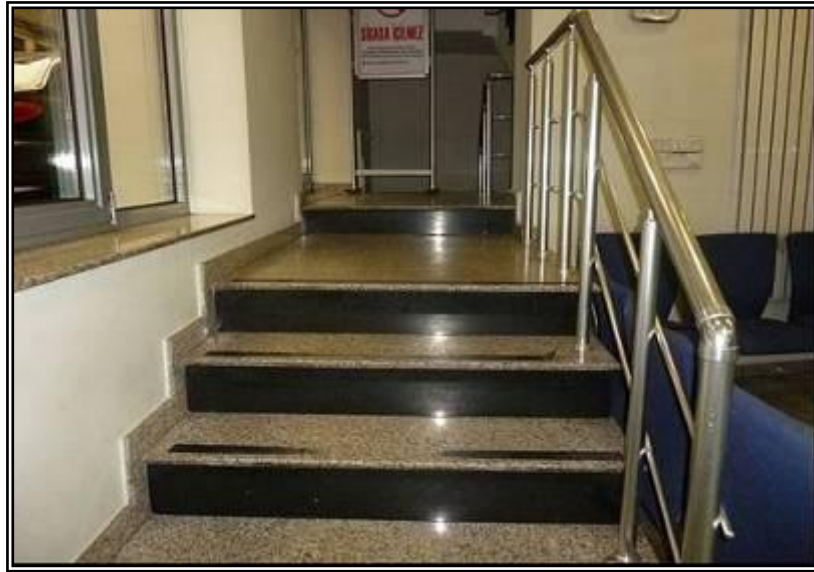
Zemin kattan katlara çıkan ara merdiven
