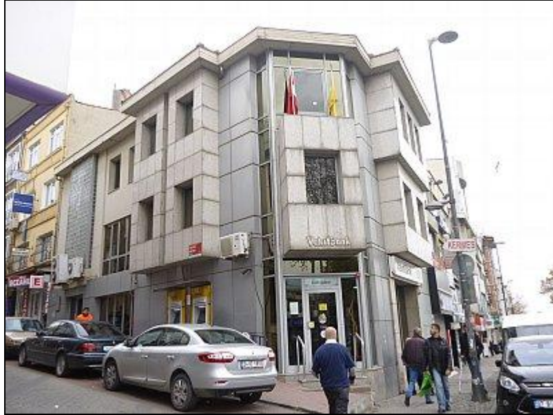
Köşe konumlu binaya bakış
