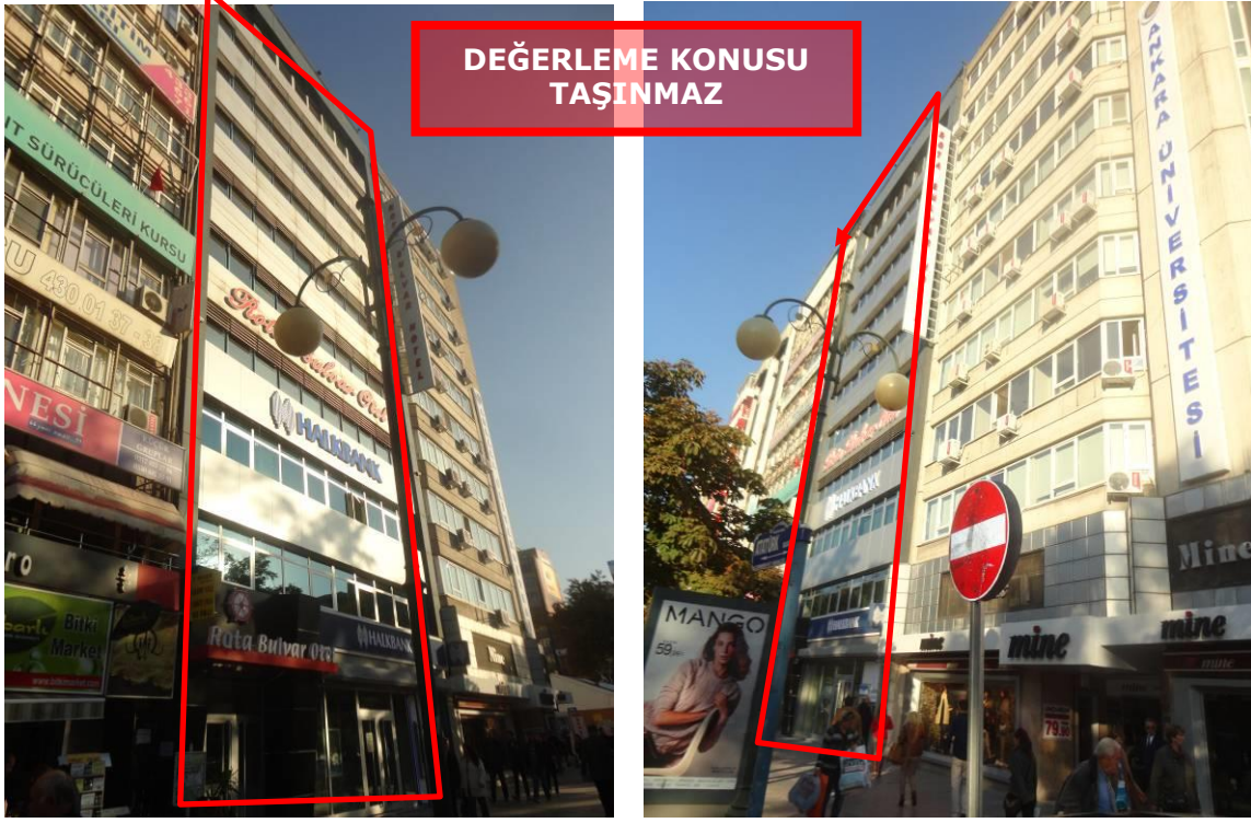
Bina Dış Görünüşü
