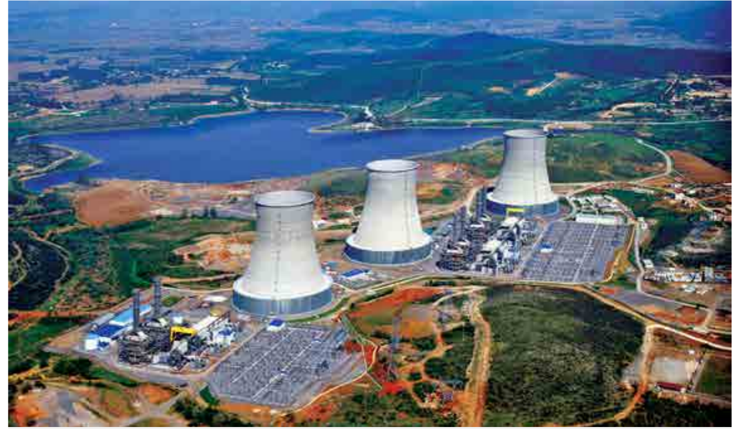
Gebze Elektrik Üretim Ltd. Şti.
